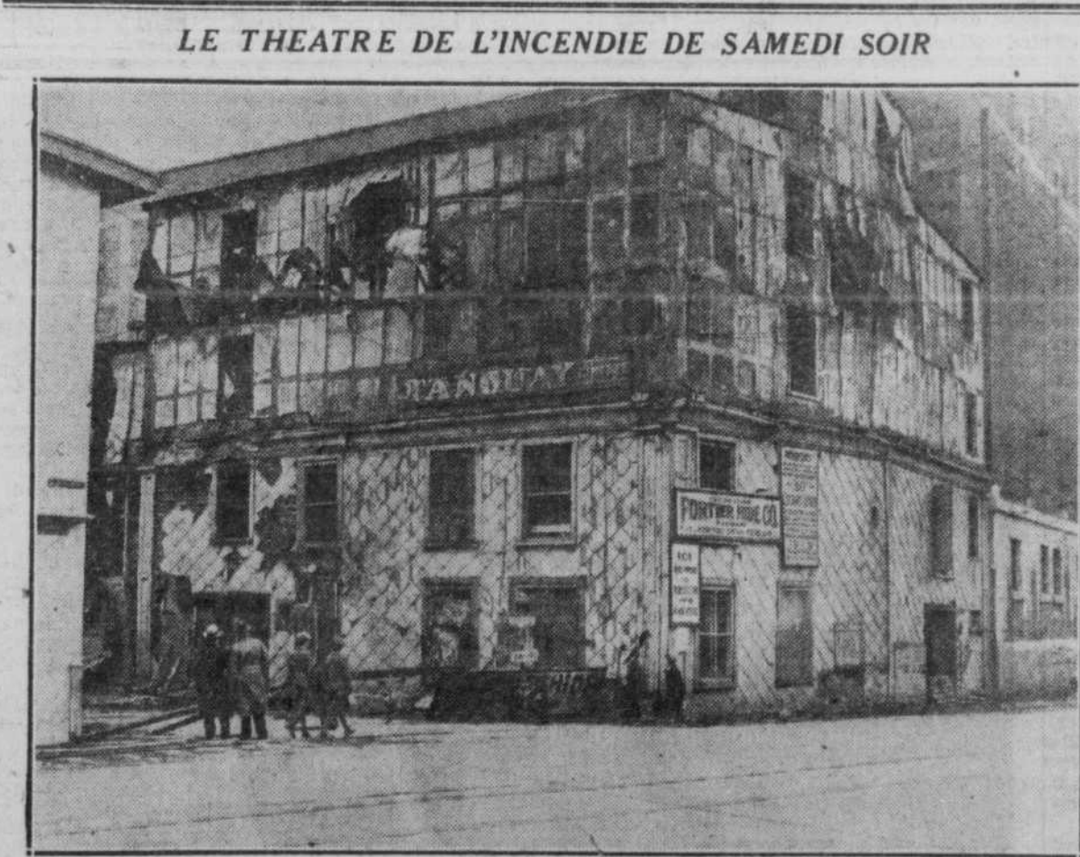
Le feu a entièrement consumé, samedi soir, la bâtisse que l'on voit ici, rue St-André, et qui était occupée par la Fortier Hide Co., marchand de peaux vertes. Le magasin de la Commission des Liqueurs, qui l'avoisine, a subi quelques dommages bien qu'il soit à l'épreuve du feu. Les pompiers ont lutté contre les flammes pendant deux heures.
