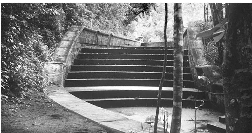
Ce qui ressemble à un immense escalier de pierre est en fait un système de purification d'eau jouxtant le bassin de captation des eaux Wallings.
