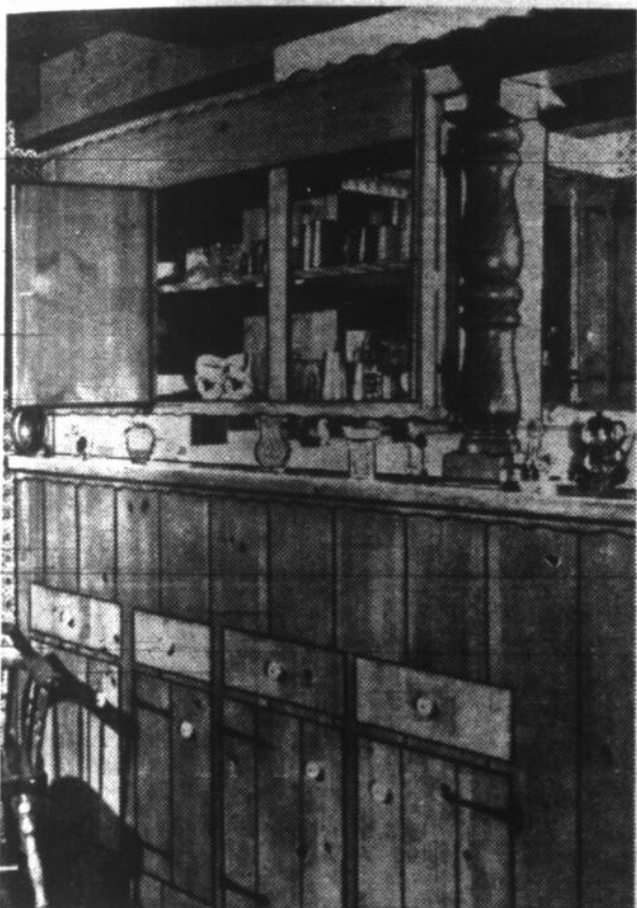
Autre façon originale et pratique de diviser cuisinette et salle à manger, en donnant un cachet ancien à un agencement moderne et fonctionnel: des armoires en pin, accessibles des deux côtés par des séries de portes semblables.
