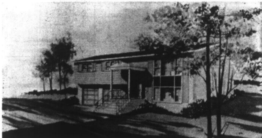
LE RICHELIEU — Voici un exemple typique des maisons de nouveau style où l'architecte a su concilier le modernisme fonctionnel avec les principales qualités de la tradition ancienne. A remarquer en particulier le portail de cette maison, qui comprend 4 chambres à coucher, 2 garages chauffés, 2 salles de bain, grande salle de détente, vivre et salle à manger, fenêtre en saillie ("bay-window") vitrée thermopane, planchers en chêne, revêtement brique et aluminium, etc., etc.
