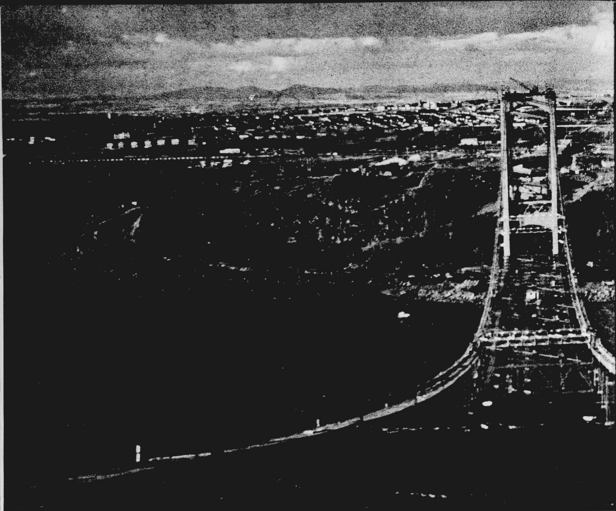
Du haut de la tour sud, la structure du pont Frontenac s'élançait vers la Vieille Capitale, parallèlement au pont de Québec; ci-contre, des ouvriers
