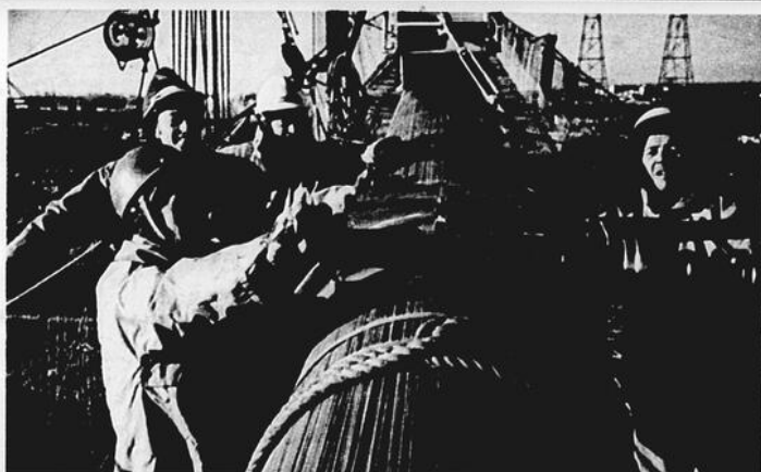
boulonnent un collier au câble principal.
