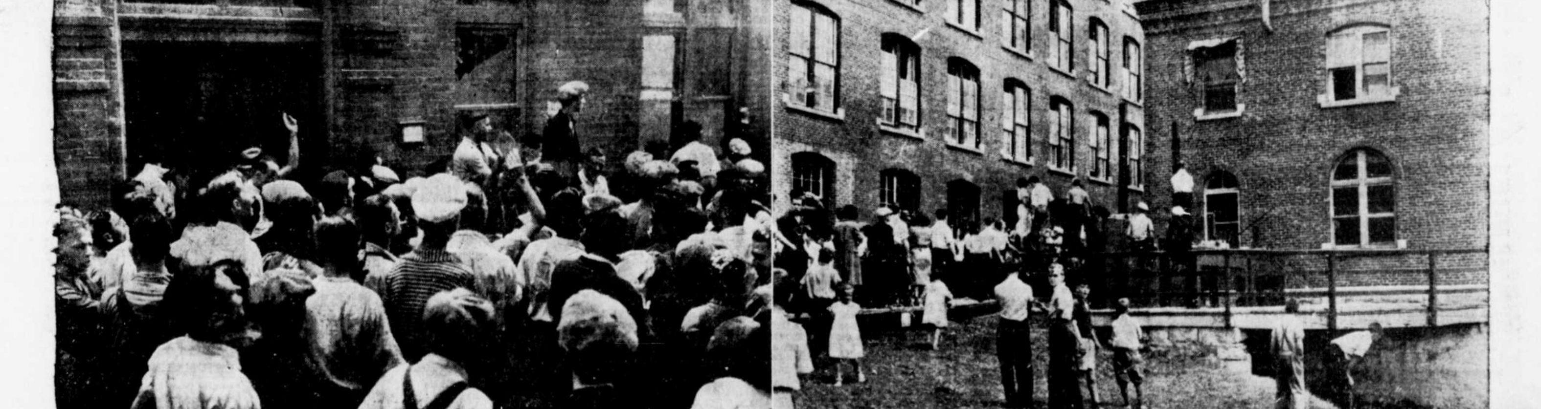
Ces scènes ont été prises à l'occasion de la compagnie Dominion... alors que la foule des quelque deux cents grévistes assiégeait le bureau d'administration. Un fort groupe d'entre eux avait pénétré à l'intérieur de l'édifice, occupant le vestibule, l'escalier. Les premiers étaient entrés dans le bureau de M. Blair Gordon, le gérant général de la compagnie. On lui a fait un vilain parti, ainsi qu'à M. Willie Flemming, le directeur de la fabrique de St-Grégoire, et son assistant, M. Fisher. M. Gordon et M. Fisher furent tous deux blessés. À gauche un groupe de grévistes devant la porte d'entrée; des vitres ont été brisées à l'aide de cailloux. À droite la foule et le pavillon de l'administration; on remarquera la fenêtre située en haut et à droite de la photo; le moustiquaire a été arraché et jeté sur le petit pont. Les grévistes voulaient y précipiter M. Gordon.
