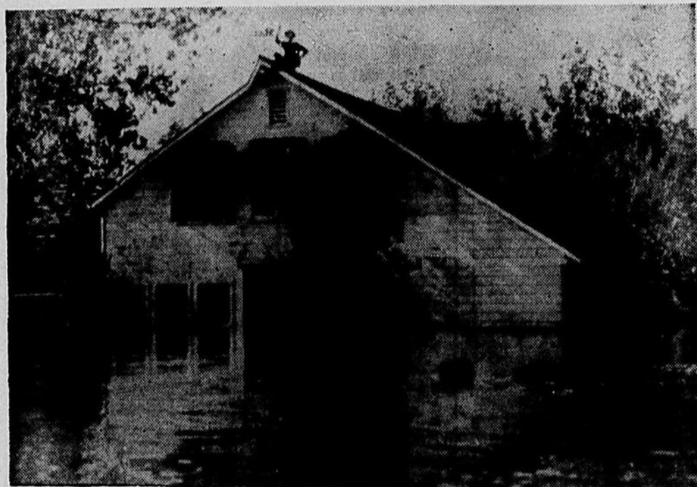
Plusieurs personnes ont perdu la vie et plusieurs milliers d'autres ont dû fuir leur foyer au cours de la récente inondation qui a couvert de vastes régions de la Californie et du Nevada. Cette inondation a causé pour des millions de dollars de dégâts dans les plantations d'arbres fruitiers de la région. On voit ici un citoyen de North Sacramento perché sur le toit de sa maison en attendant l'arrivée du secours.
