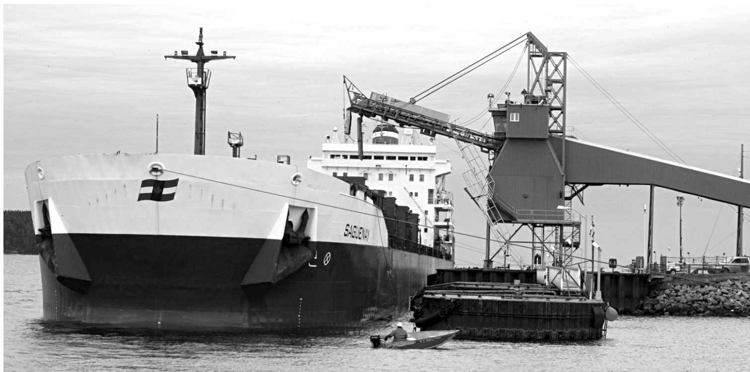
Le cargo Saguenay, amarré à Havre-Saint-Pierre. Rio Tinto Fer et Titane, une filiale de Rio Tinto Alcan, annonçait en mai 2011 des investissements totalisant 800 millions qui prévoyaient notamment le prolongement du quai. Ces travaux ne feront plus l'objet d'une évaluation environnementale en vertu de la loi budgétaire C-38.
