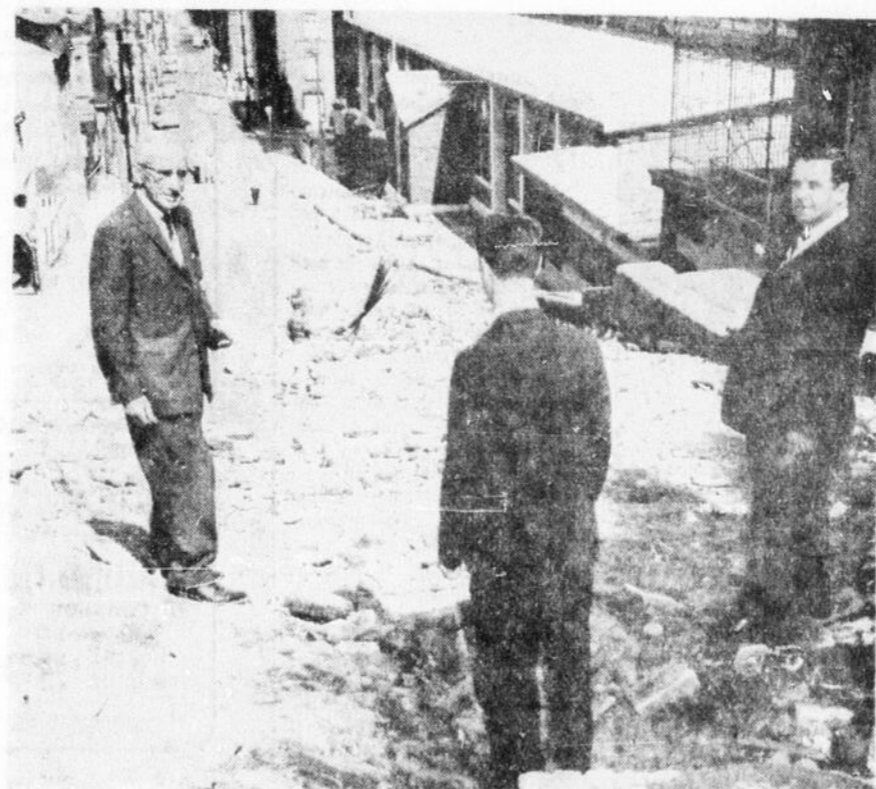
UNE SECTION DE LA RUE DE MAZENOD sera incessamment refaite en neuf, soit la partie comprise entre la falaise et la rue Arago. Le bris d'un tuyau a en effet totalement emporté le pavage comme le montre la photo ci-dessus, et la rue est depuis plusieurs semaines fermée à toute circulation. Les deux échevins de St-Sauveur-Est, MM. Jules Morency et Mar-
