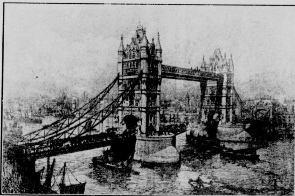
LE PONT DE LA TOUR
