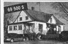
FRAMPTON: Une belle canadienne de 5 1/2 pces, armoires et planchers de chêne. De plus, elle vous offre un revenu de 3 1/2 présentement loué. Solarium, superbe terrain de 9 417 p.c..
