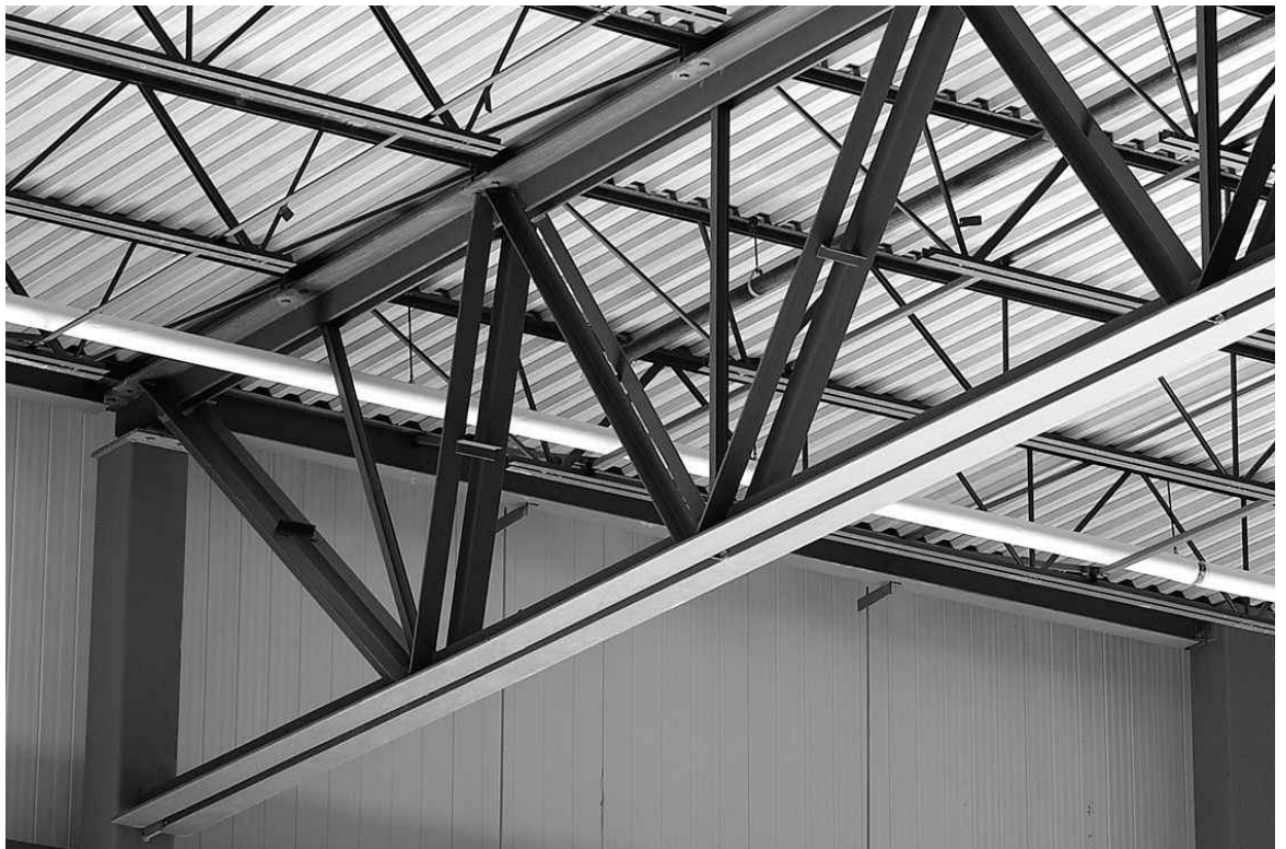
Le Groupe Canam a augmenté sa capacité de production aux États-Unis dans le domaine du tablier métallique. — PHOTOTHÈQUE LE SOLEIL
