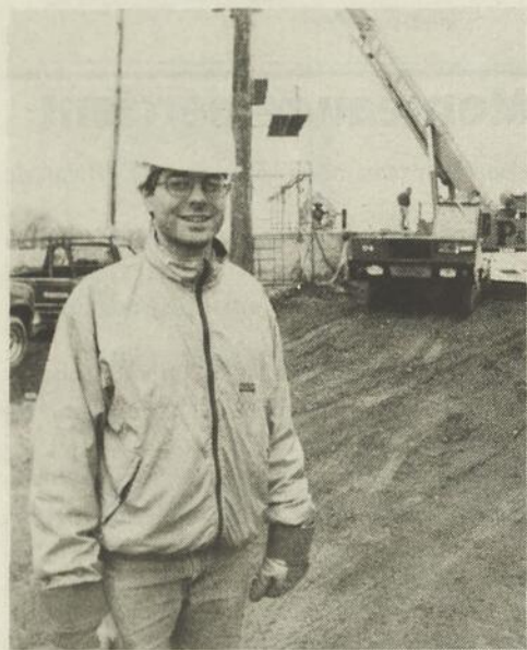
Devant le site de la mini-centrale magnymontoise, l'ingénieur responsable des travaux et porte-parole de l'entreprise Hydro-Montmagny, M. François Vézina.
