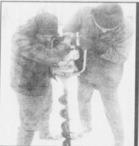
Des employés de la Ville creusant des trous dans la glace pour y insérer des bâtons de dynamite, comme on le pratiquait à l'époque, en 1977.
