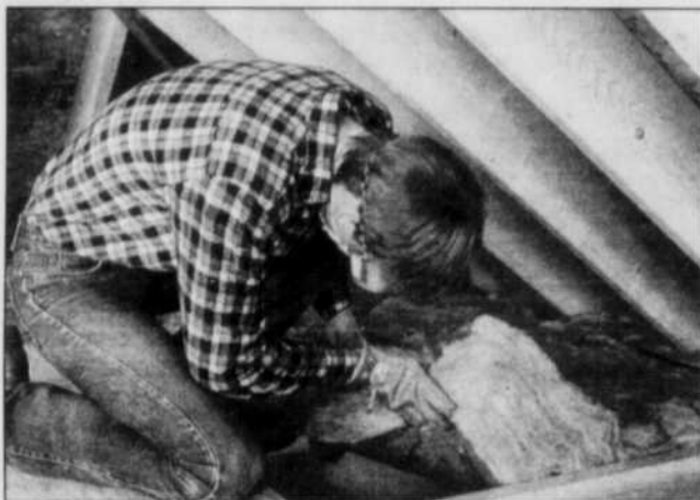
Les nattes de laine isolante dans l'entretoit contribuent à garder l'intérieur au frais.
