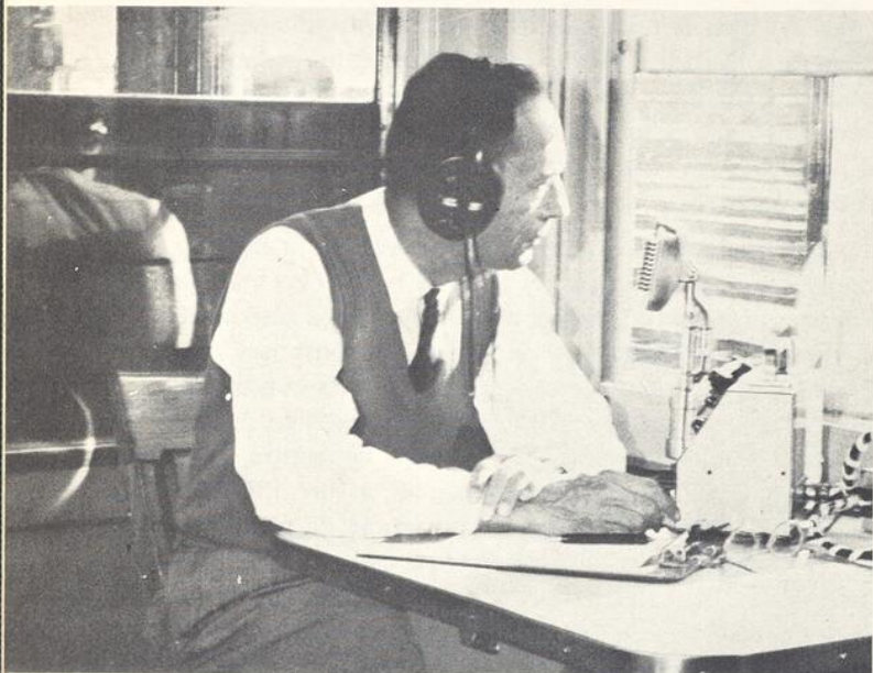
En cours d'essai, un technicien s'installe au poste d'observation de la voiture d'essai du CN, signale à haute voix chaque borne-mille et enregistre également à haute voix tout ce qu'il observe.
