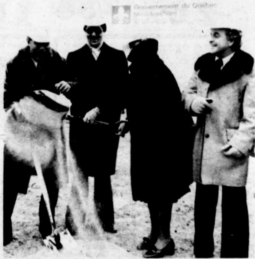
La première pelletée de terre pour la construction du centre d'accueil François Seguenot.
