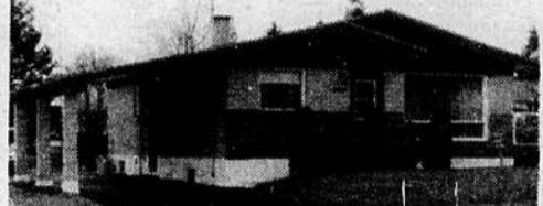
590. Belle RÉSIDENTE située près de l'Hôpital, quartier résidentiel, tout en étant près du secteur commercial; terrain bien aménagé; 3 chambres à coucher; sous-sol fini; très bonne qualité de construction.
