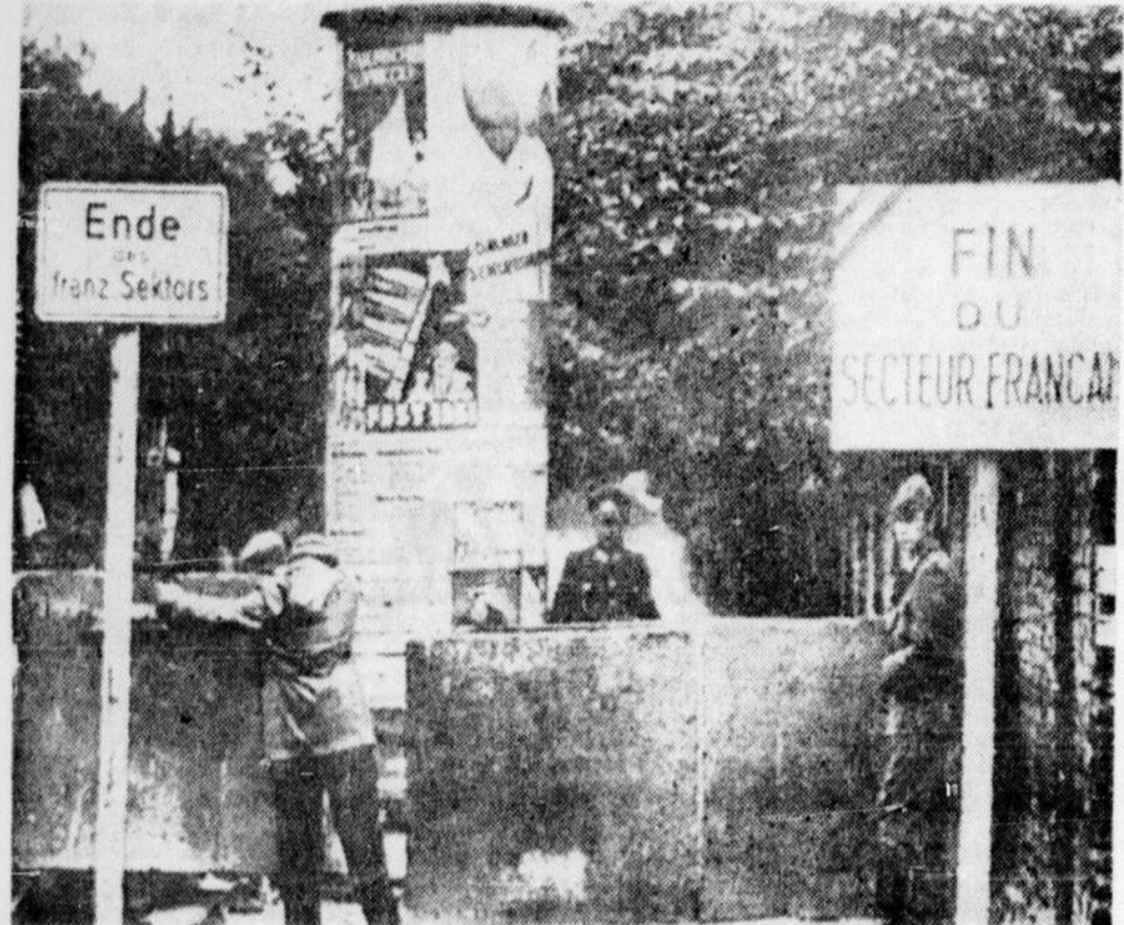
MAINTENANT UN MUR DE BETON... Des ouvriers de l'Allemagne de l'Est, sous la protection de militaires bien armés, erigent un mur de ciment le long de la frontière qui sépare la zone soviétique de la zone française, dans la ville déchirée de Berlin... (Téléphoto PA)
