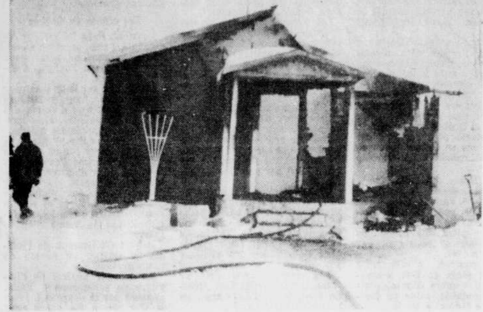
TRISTE NOEL — Une famille de St-Nicéphore a été durement éprouvée alors que la veille de Noël sa résidence et son mobilier entier ont été détruits par les flammes, tandis que le père blessé en voulant sauver ses deux enfants a dû prendre la route de l'hôpital. Sur cette photo, les pompiers de Drummondville tentent de maîtriser l'élément destructeur. (Photo La Tribune, Drummondville)
