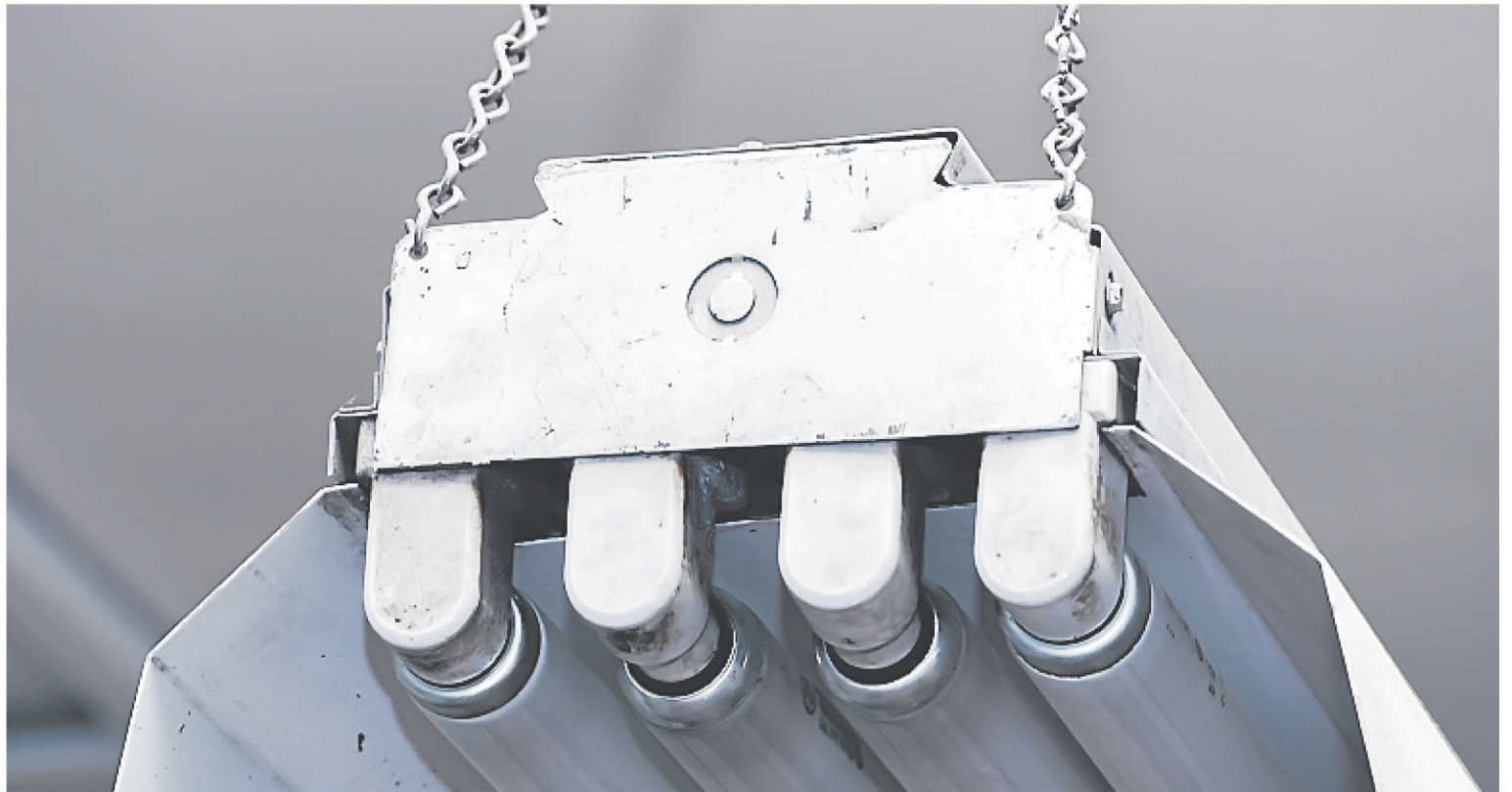
L'extrémité des tubes fluorescents devient noire vers la fin de leur vie utile. — PHOTO 123RF/ANNSTEPHENSON
