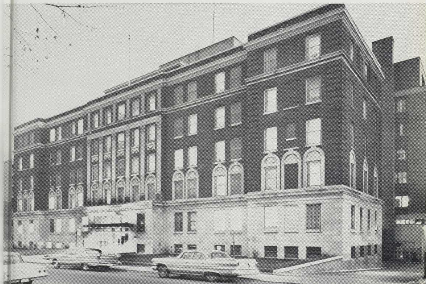
Duschênes & Barrett, architectes; Jas. P. Keith & Associates, ingénieurs conseil; John Colford Contracting Co. Ltd., entrepreneur mécanique; W. E. Baxter Ltd., sous-entrepreneur, ventilation et climatisation
