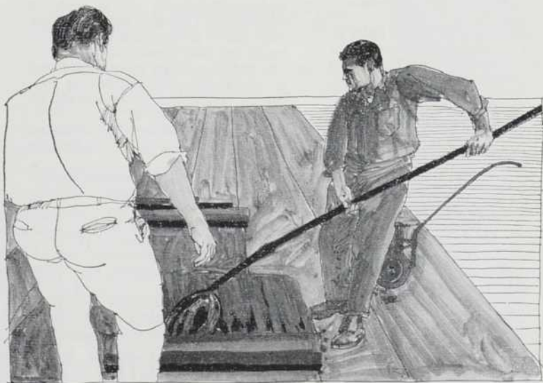
Le feutre est passé sur une feuille de base enduite à l'usine. L'asphalte chaud ne vient pas en contact avec le Roofmate FR.
