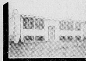
Rue Blanchette, St-Anaclet, bungalow, entrée split 26x42, construction neuve.
