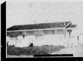
610, 3ième rue, Rimouski-est, bungalow tout en brique, sous-sol aménagé avec foyer.
