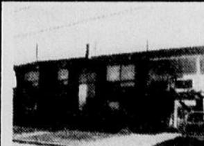
Sacré-Coeur , 264-268, rue Maurice, deux immeubles à 2 logements.
