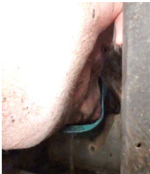
Figure 29 Débordement d'eau lorsque les truies s'abreuvent aux bols en fonte
