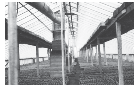
Figure 7 - Intérieur de serre - vers 1968
