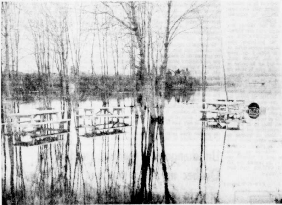
DU AU TROP GRAND ECOULEMENT d'eau des vannes du barrage du Grand Lac St-François, le niveau de l'eau du lac Aylmer se maintient beaucoup trop haut. Plusieurs emplacements sont inondés. La photo nous montre, une partie du terrain de jeu de Disraeli qui est enfoui sous l'eau. (Photo La Tribune, Thetford Mines)
