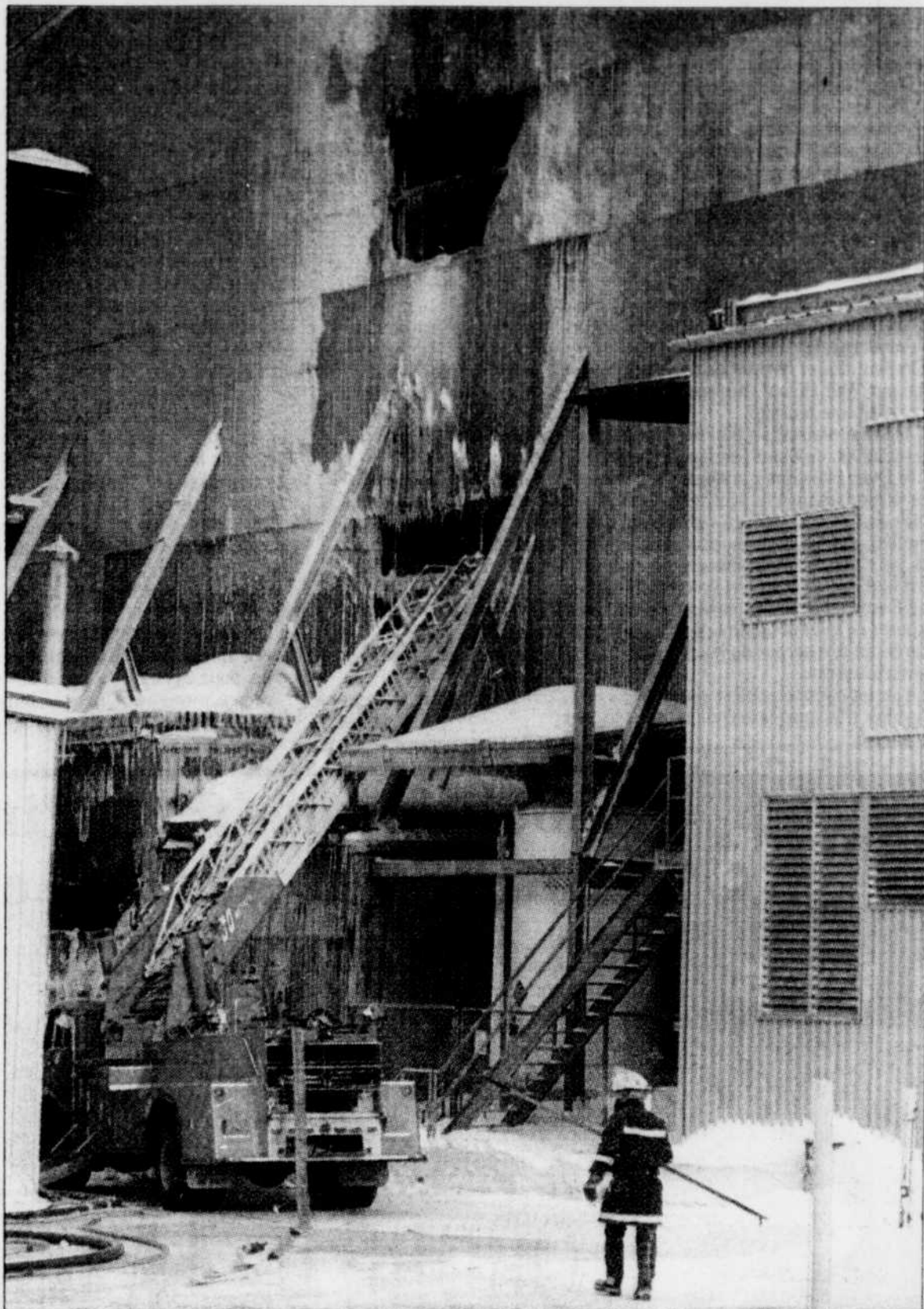
Un incendie s'est déclaré vers 11h30 hier matin, à l'atelier d'assemblage du chantier maritime MIL Davie à Lévis. Comme l'a expliqué la porte-parole de l'entreprise, Gina Perreault, le feu aurait pris naissance dans une fournaise. Les pompiers ont circonscrit l'incendie en moins d'une heure, limitant ainsi les dégâts. Seule une petite partie du revêtement extérieur devra être changée. Personne ne se trouvait dans la bâtisse au moment du sinistre.
