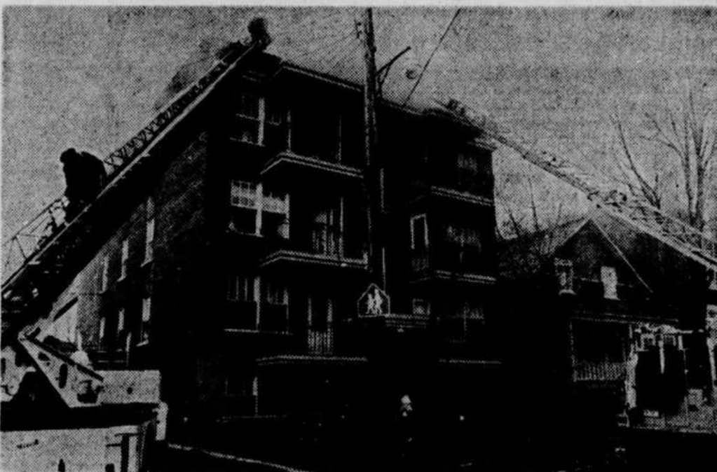
Une maison de quatre étages, abritant 8 logements, et portant le numéro civique 815 de l'avenue Lévis, dans le quartier Belvédère, a été lourdement endommagée par un incendie, en fin d'après-midi, hier. Environ 60 pompiers, répondant à trois alertes, ont mis une couple d'heures à maîtriser les flammes. Personne n'a été blessé, mais au moins 25 personnes ont été chassées de leur domicile. Les dégâts par le feu, l'eau et la fumée dépassent les $50,000.
