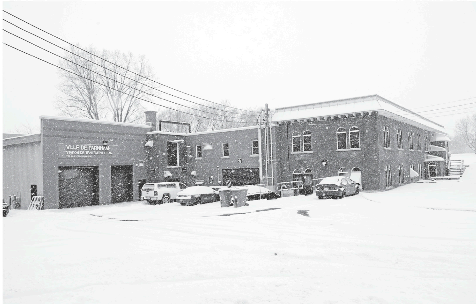
Des travaux évalués à près d'un million de dollars seront réalisés pour construire un réservoir de captage des eaux de rejet de lavage à la station de filtration de Farnham. — PHOTO ARCHIVES LA VOIX DE L'EST
