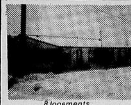
Bldgements Rue Fabrique Sainte-Blandine
