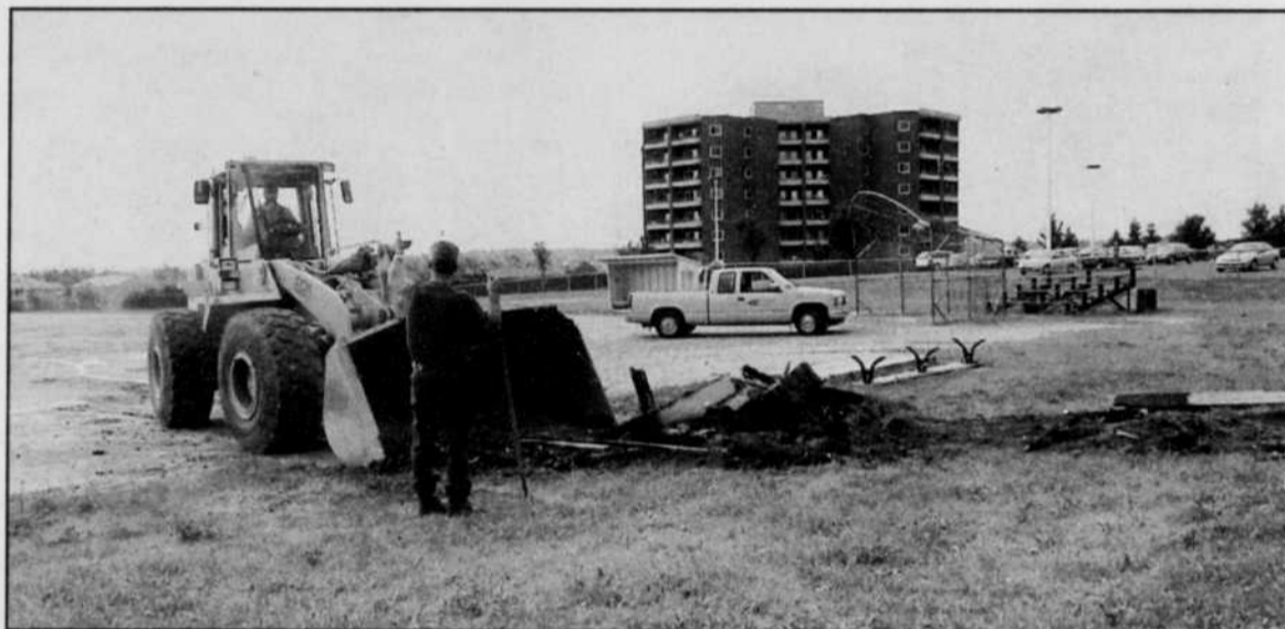
Les employés municipaux ont nettoyé déjà les dégâts de l'incendie à 10h hier matin.
