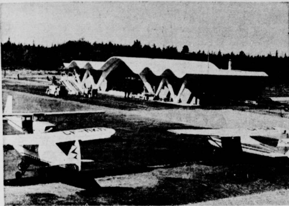
L'aérogare de Trois-Rivières fait l'orgueil et l'admiration de toute la population de la région par l'originalité de sa conception architecturale, la simplicité de ses lignes, tout en étant un point de repaire bien facile pour tous les avions.
