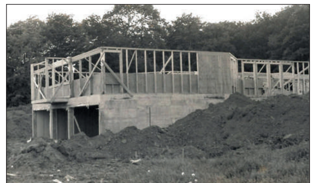
Le début des travaux en 1983.
