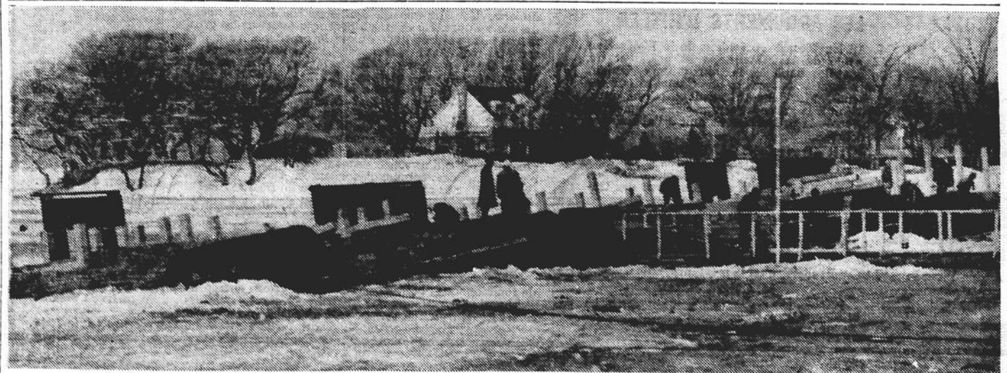
PLUS DE PEUR QUE DE DOMMAGES: — A la grande stupéfaction de tous, surtout des employés qui s'y trouvaient, le départ subi d'une partie du crible installé sur la baie St-François, face à l'aqueduc municipal, lundi avant-midi dernier, a causé plus de peur que de dommages. Le gérant de la Cité, M. ALCIDE LA-FONTAINE, nous déclarait que le fait que le crible n'ait pas bri-
