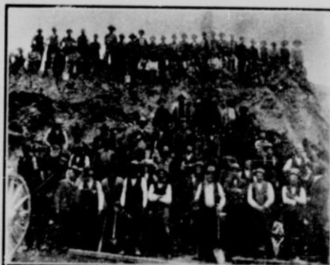
Autre groupe d'ouvriers employés à la construction de l'élevateur
