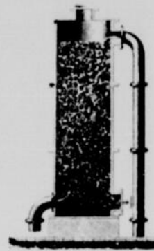
Colonne à coke verticale
