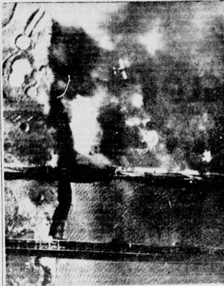
Vue aérienne, montrant un bombardier en action alors que celui-ci, après avoir lâché 2,000 livres de bombes sur un pont traversant la rivière Yalu, en Corée, et l'avoir rendu inutilisable, s'élève au-dessus d'un épais nuage de fumée.
