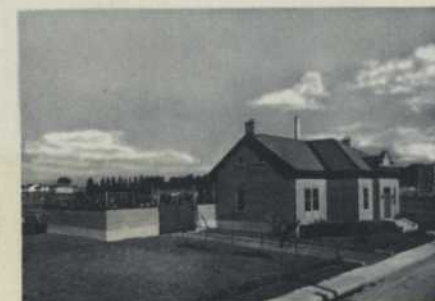
O'Brien Stn. 12,000 KVA — 12/4KV
