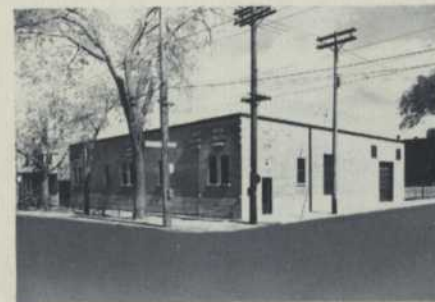
Laurier Stn. 15,000 KVA — 12/4KV
