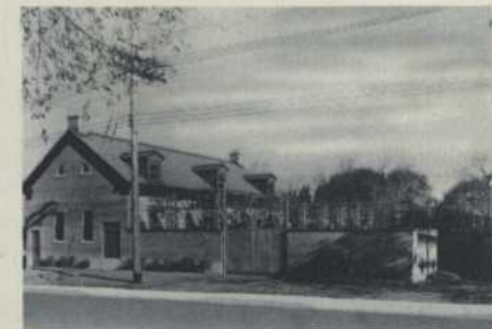
St. Luc Stn. 10,000 KVA — 12/4KV
