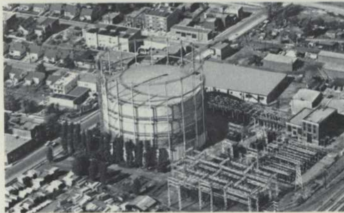
Beaumont Stn. 110,000 KVA — 60/12/4KV
