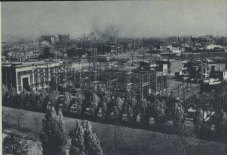
Atwater Stn. 240,000 KVA — 120/60/12/4KV
