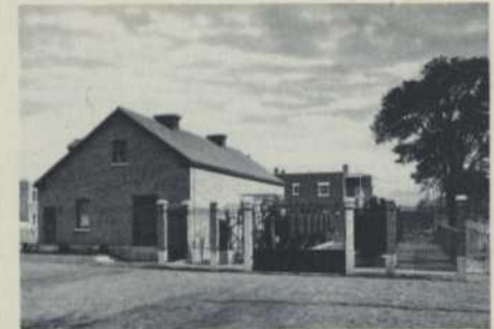
Champlain Stn. 15,000 KVA — 12/4KV
