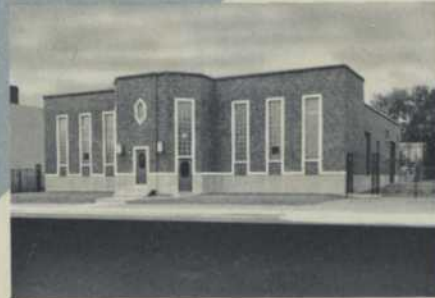
Brillant Stn. 15,000 KVA — 12/4KV
