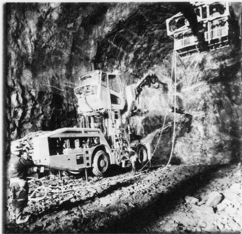
Forage de la galerie d'amenée au projet Toulnostouc
