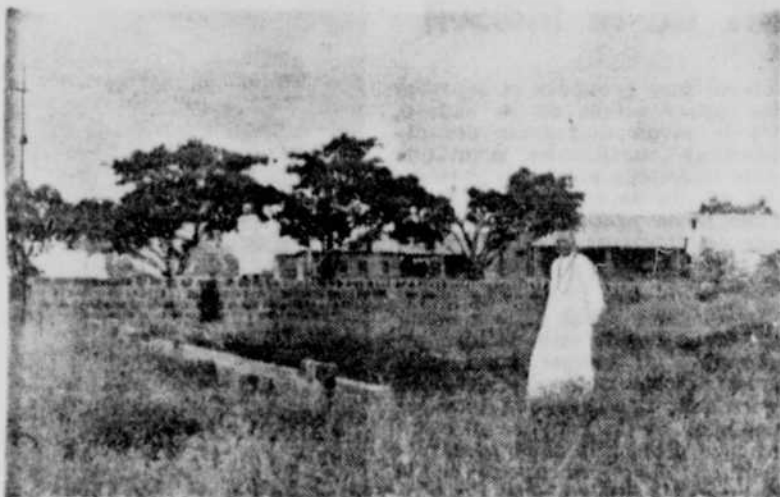
Le Père Leblanc et les fondations de l'église de Tamalé.
