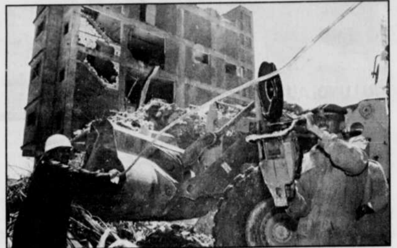
Les équipes de secours ont retiré 15 corps des débris d'une usine de vêtements qui s'est effondrée dans la nuit à Alexandrie à la suite d'un incendie. photo Associated Press
