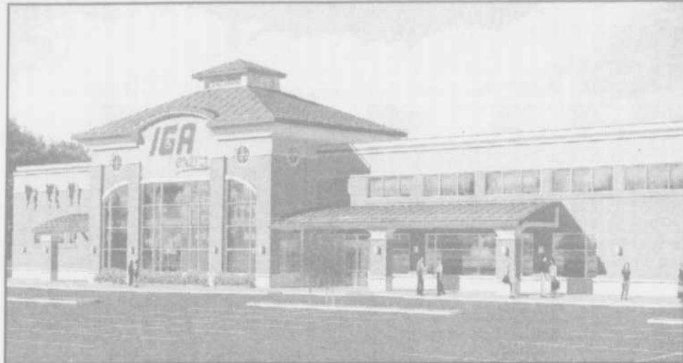
Le IGA Extra qui sera aménagé sur un terrain en bordure de la montée Masson, à l'entrée du Mega-Centre Mascouche sera construit sous peu et livré pour une ouverture au printemps de 2002.
