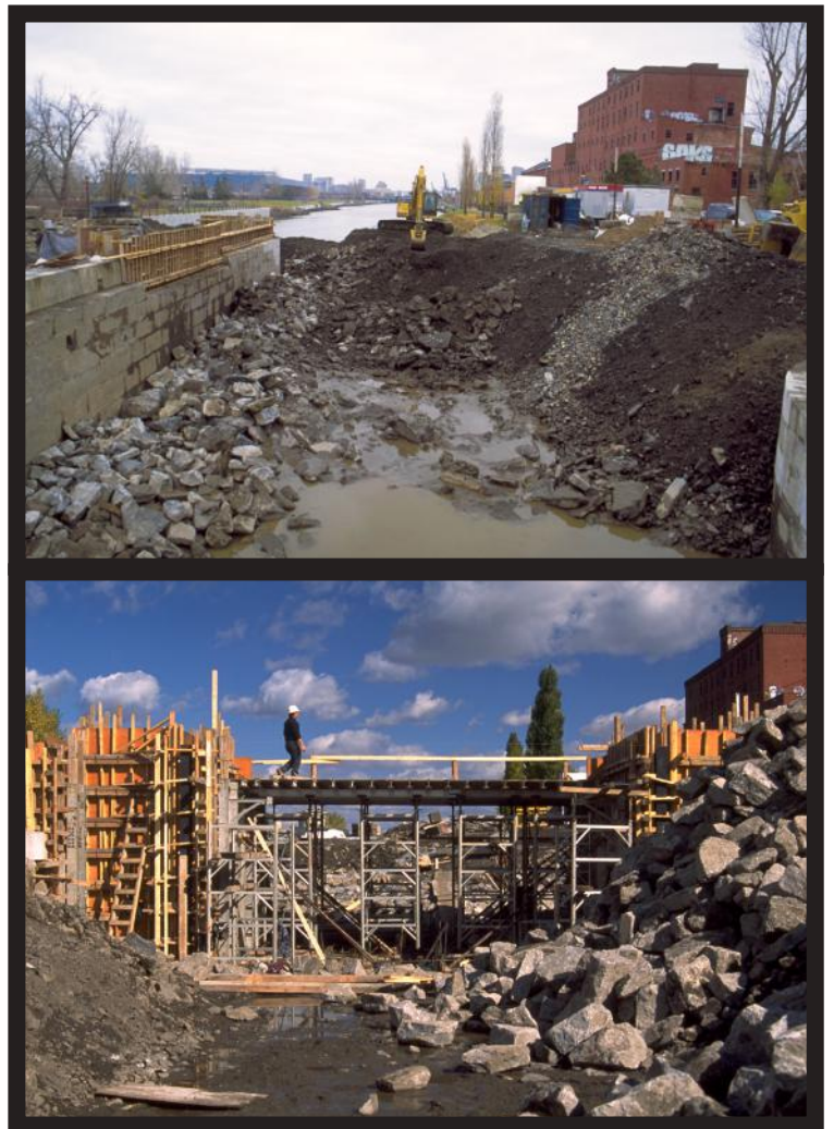
Travaux à l'écluse Saint-Gabriel en 2000. Crédit photo : Parcs Canada (deux photos).
