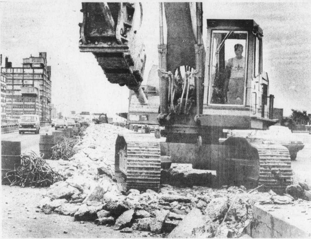
Les travaux de réfection du boulevard Métropolitain se poursuivent depuis quelques semaines déjà, occasionnant un certain ralentissement du trafic automobile. Il y aura même arrêt complet de la circulation dans les deux sens aujourd'hui, entre les boulevards Saint-Michel et Saint-Laurent, pour permettre aux ouvriers d'accomplir certaines tâches délicates. Des travaux ont également lieu sur les autoroutes Ville-Marie et Décarie, de même que sur le pont Mercier. Mais les interruptions complètes y sont réduites au plus strict minimum. (Photo Jacques Grenier)
