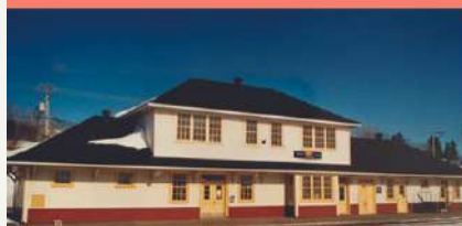
Gare de New Caillon, 2005. Époque actuelle. Le bâtiment possède deux étages, la deuxième étiquette des locaux. Le gare est très confortable et possède une vue sur la baie de Saint-Vincent. Elle est désignée patrimoniale en 1994.
