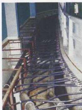
Tuyaux d'acier sous la dalle de la patinoire de l'aréna Mont-Royal.
