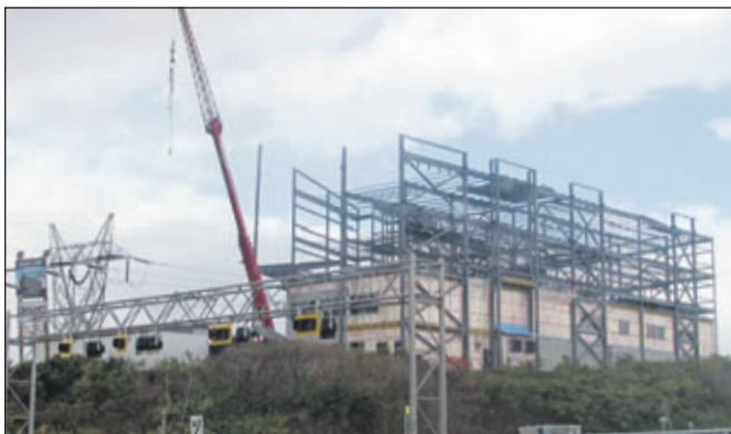
Le travail sur l'ossature de l'immeuble de la Clinique Saint-Louis avance à grands pas et devrait être terminé sous peu, pour que les travaux intérieurs se fassent cet hiver.
