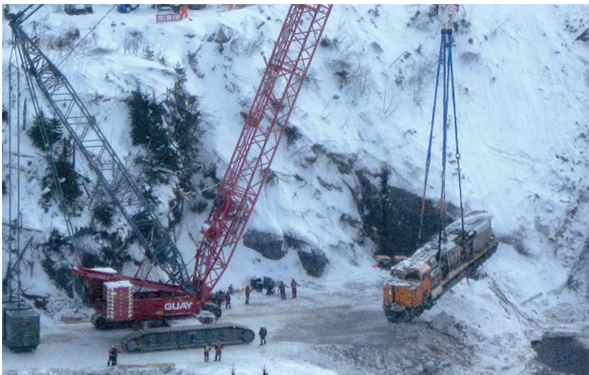
L'expertise de Sept-Îles a été mise à contribution dans le levage des wagons et locomotives du train de la mine IOC, qui a déraillé le 6 novembre 2014 dans la rivière Moisie, causant la mort d'Enrick Gagnon. L'opération délicate a pris fin en février. (Photo : Courtoisie)
