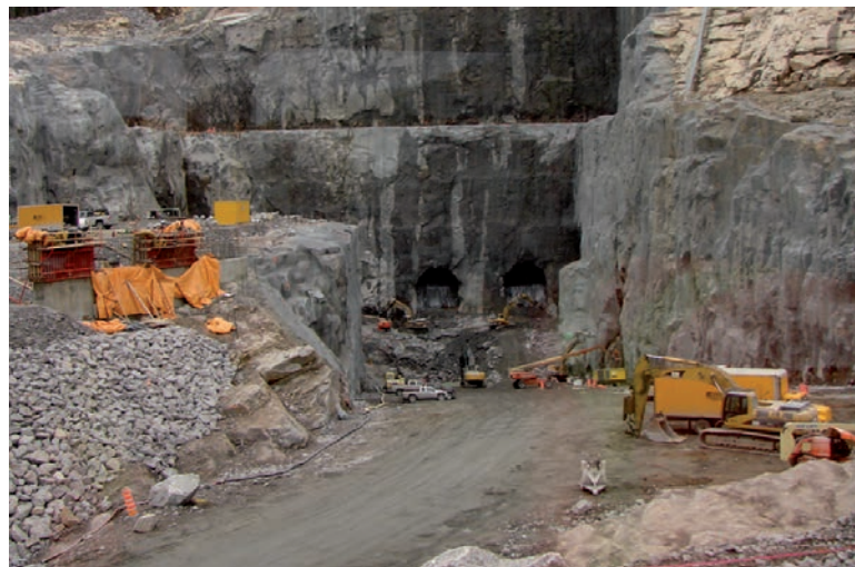
Steeve Bariault, 39 ans de Havre-Saint-Pierre, a perdu la vie le 11 mars, sur le chantier du complexe hydroélectrique de La Romaine. (Photo : Hydro-Québec)
