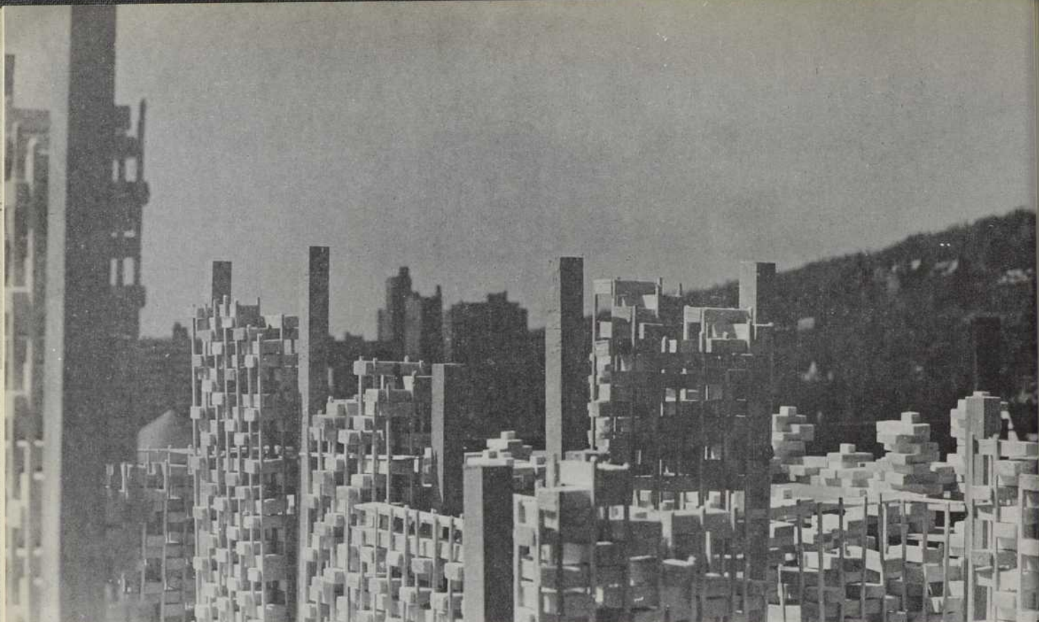
Vues d'ensemble du projet.
