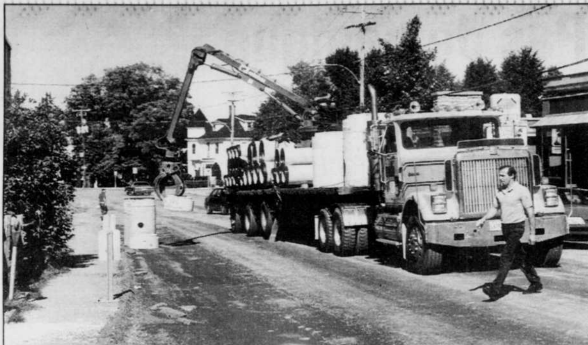
Les travaux de la phase II du programme ReviCentre transforment le visage de la rue Sud, à Cowansville, depuis le début de la semaine. photo Michel St-Jean
