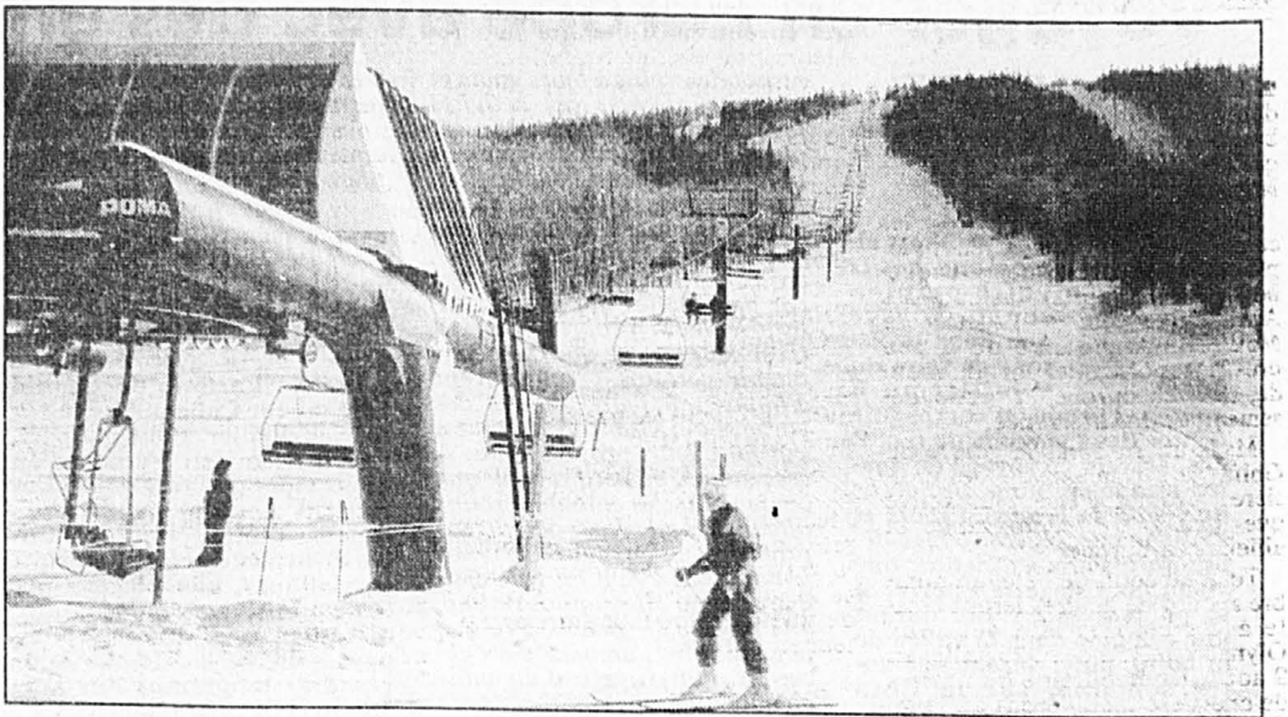
Le télésiège quadruple à vitesse variable qui peut transporter 2200 skieurs à l'heure.
