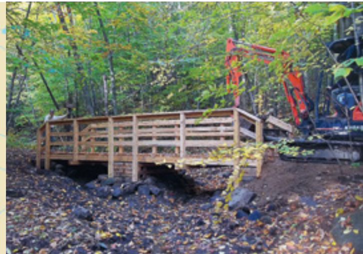
Restauration d'un sentier, mont Saint-Hilaire
